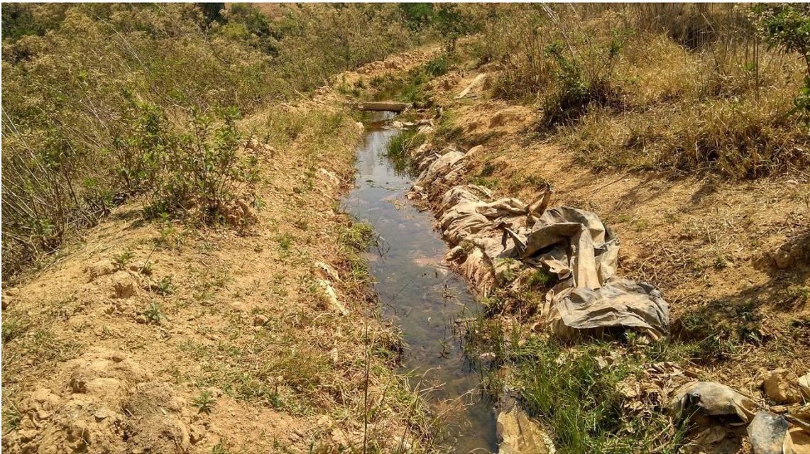
Imagem do canal escavado por onde a água é desviada.
